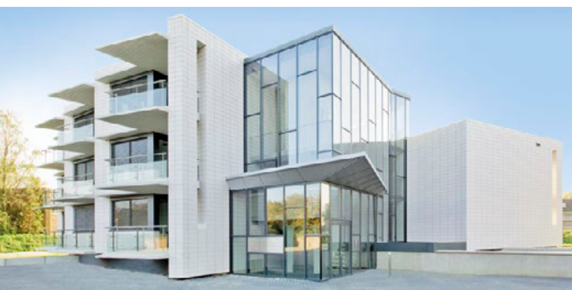
Complejo de apartamentos Sonaville, Nijmegen, Países Bajos / Arquitecto: Molenaar en Co Architecten / Año: 2010 / Foto: Marcel van der Burg
