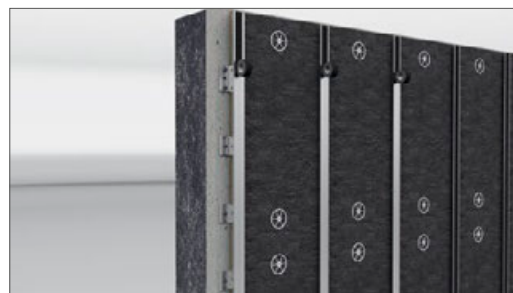
Pegar la cinta adhesiva para juntas sobre los perfiles verticales de carga
